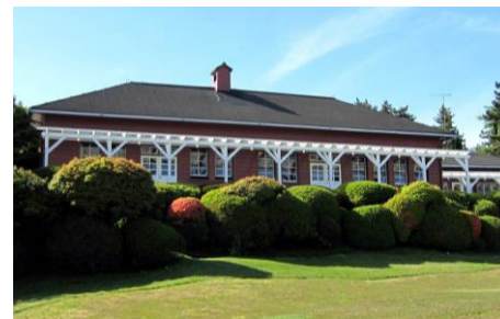
神戸ゴルフ倶楽部クラブハウス ★※外観のみ見学 竣工：1932（昭和7）年 設計：ウィリアム・メレル・ヴォーリス 六甲山の開祖、英国人貿易商のアーサー・ヘスケス・グルームが日本で最初のゴルフ場として1903（明治36）年5月に開業した「神戸ゴルフ倶楽部」のクラブハウス。一面のガラス窓と下見板の朱と黒の大きな寄棟屋根のコントラストが美しい。
